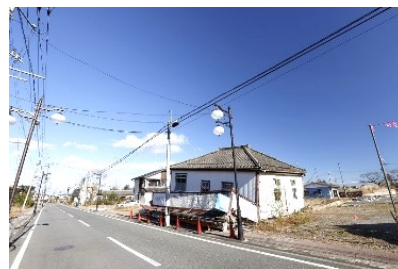
双葉駅前東側に残された倒壊家屋
