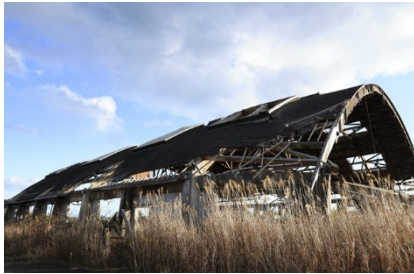
大熊町中間貯蔵施設内
