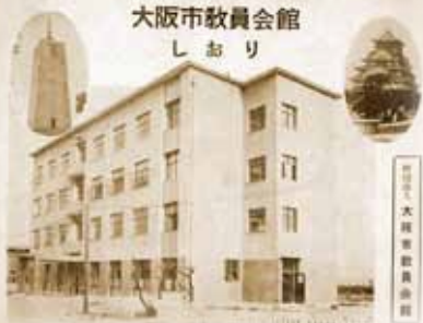
旧会館（昭和28年当時のパンフレットより）
